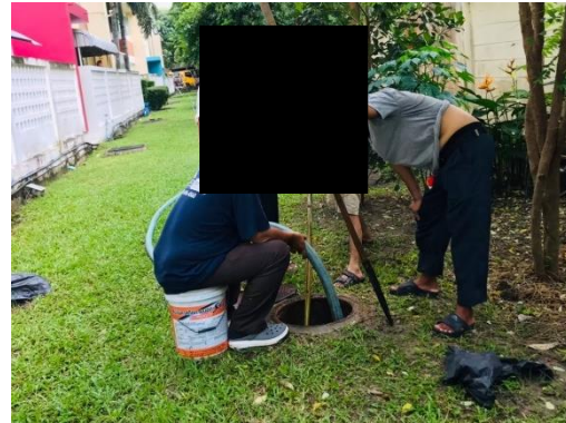
การตัดไขมันจากระบบบำบัด
